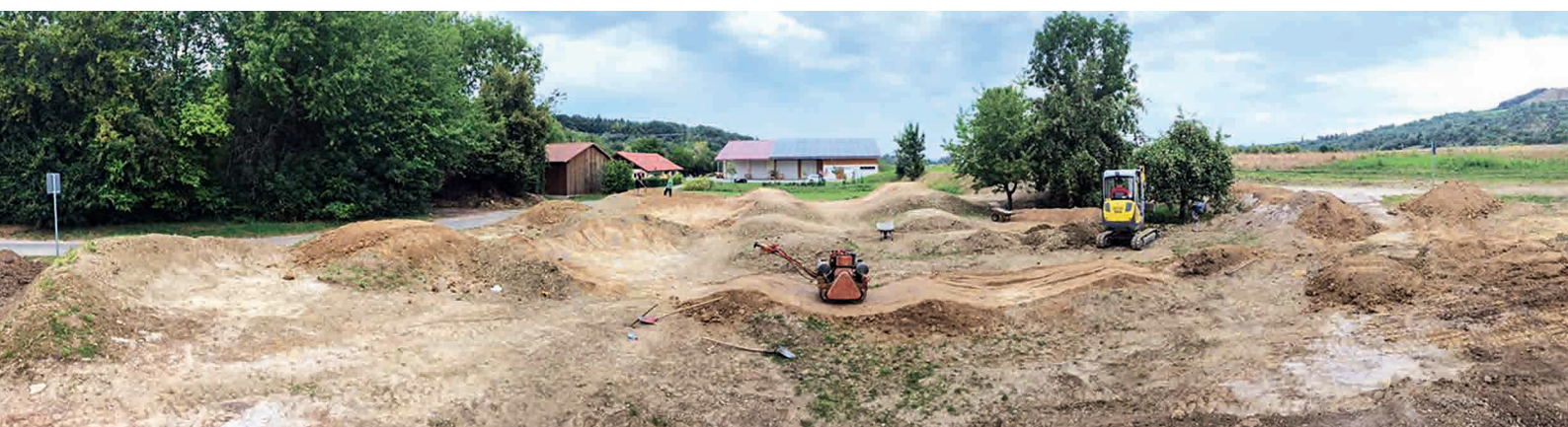
Owen: Der Dirtbikepark im Bau
