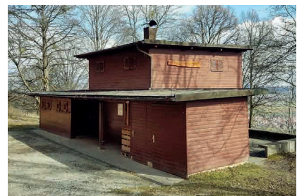
Otto-Weinmann-Haus in Obersteinbach (oben) Sigelshütte (Mitte) und Otto-Mörrike-Haus (unten) in der Nähe von Bissingen an der Teck
